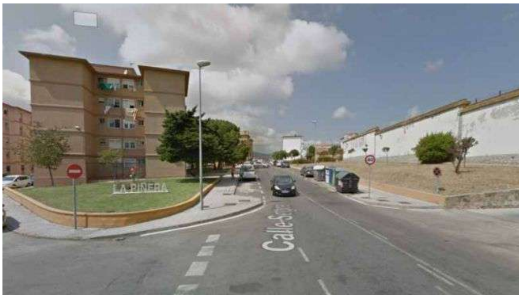
Una rotura de una tubería en La Piñera provoca una interrupción temporal en el suministro
